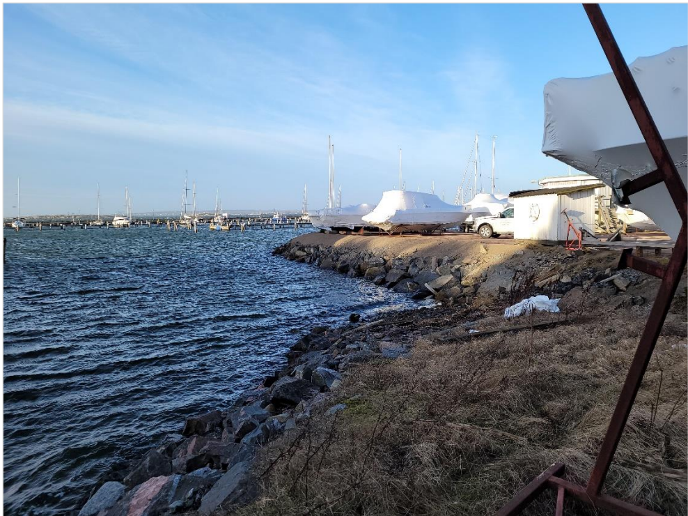
Figur 5. Utmed kajkanten ses dess uppbyggnad av sprängsten tydligt.
